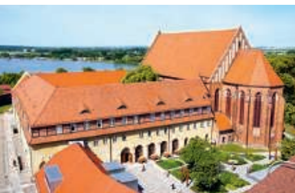
Blick auf das Dominikanerkloster Prenzlau
